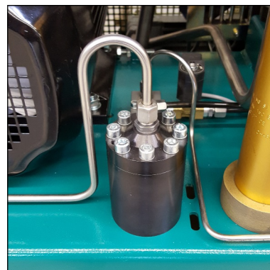
Abb. 1 - Kondensat-Stopp-Ventil-Gehäuse
