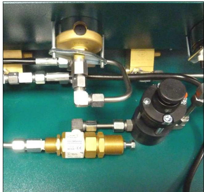
Druckminderer (li.) & Sicherheitsventil (re.)
